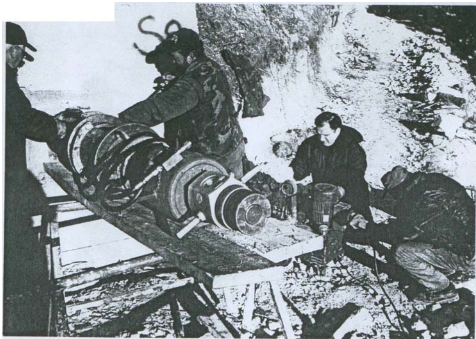
Priključivanje hidrauličke pumpe
