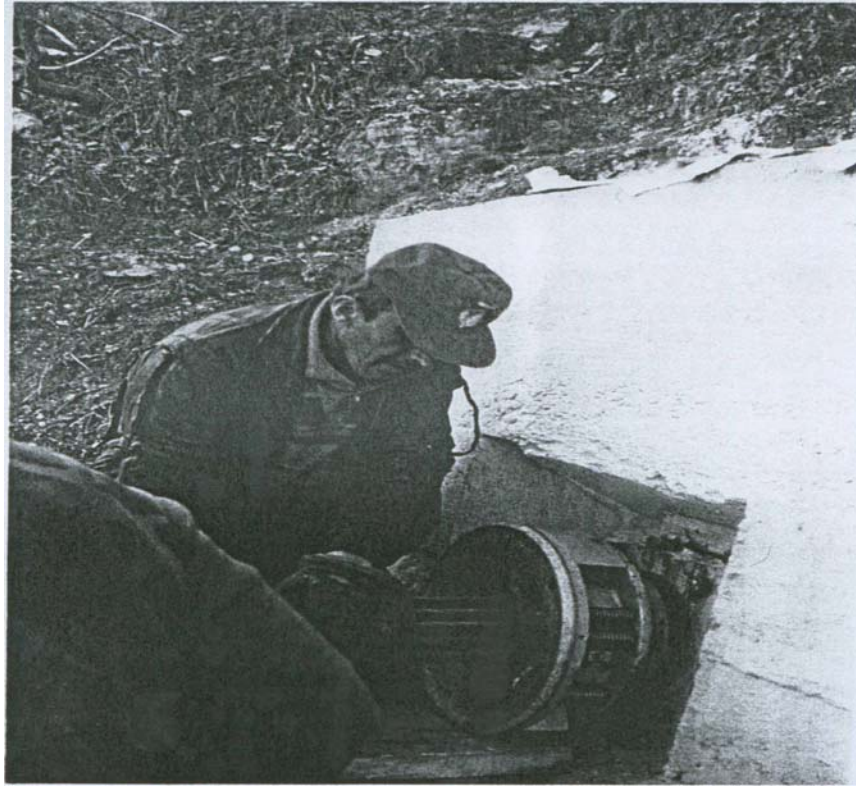
Montaža utžskivača klžnova (CM uređaj za zaklžnjavanje) ž postavljanje radne glave
