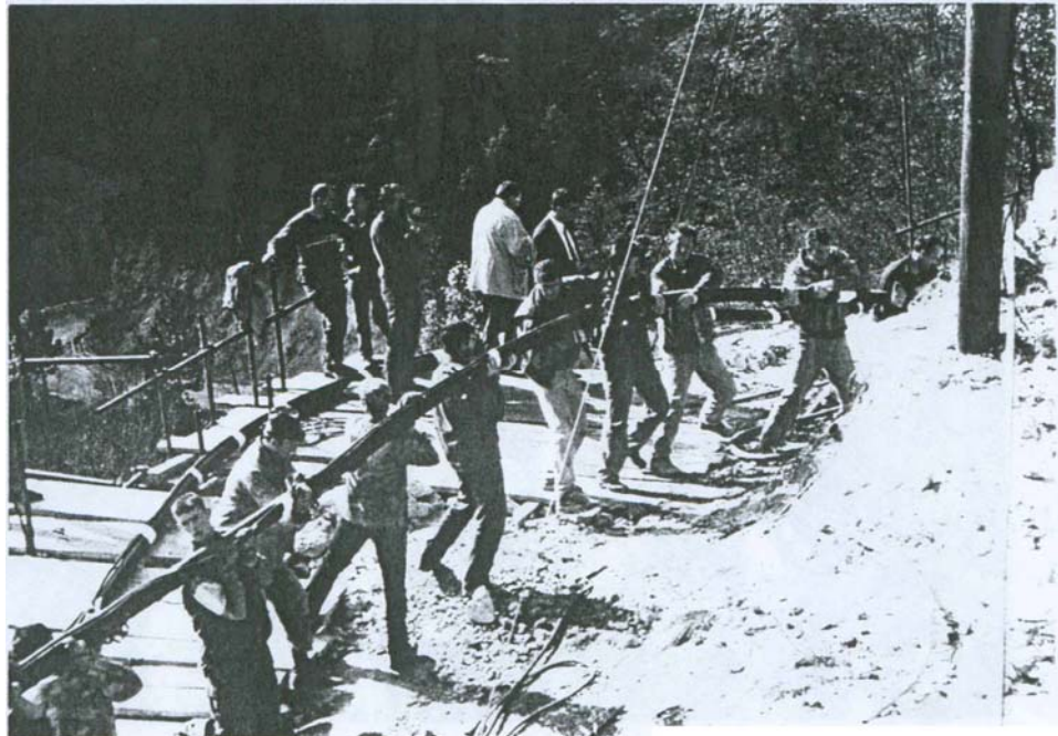
Ugradnja sidra S-7 - dio uz bušotinu
