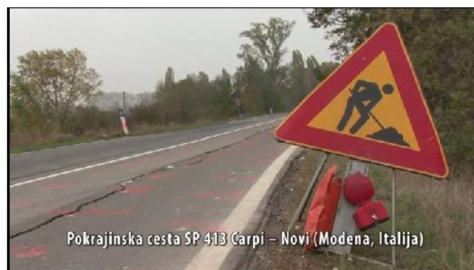
Slika 9. Slegnuta cesta Carpi-Novu na dužini 3,0 km
