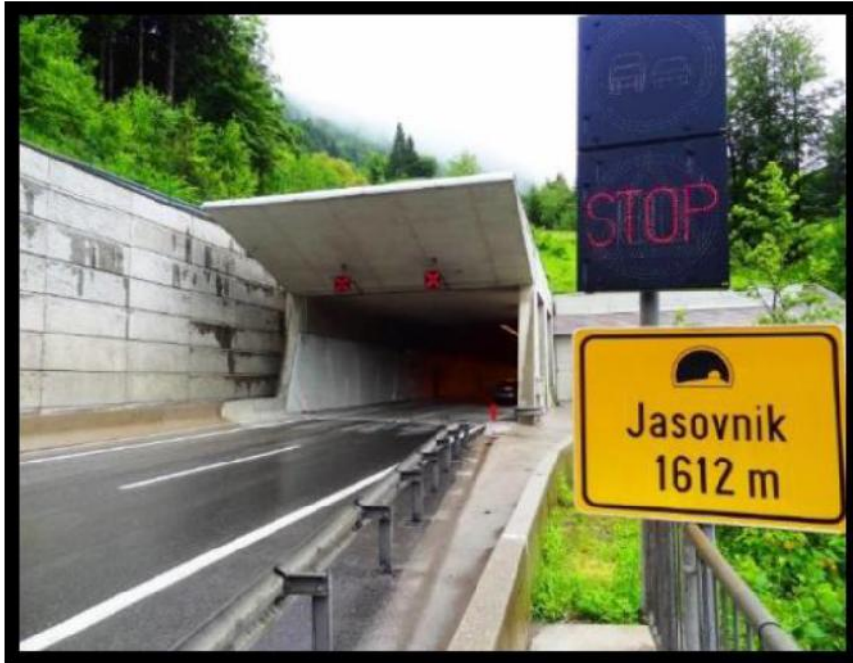
Slika 3. Portal tunela Jasovnik
