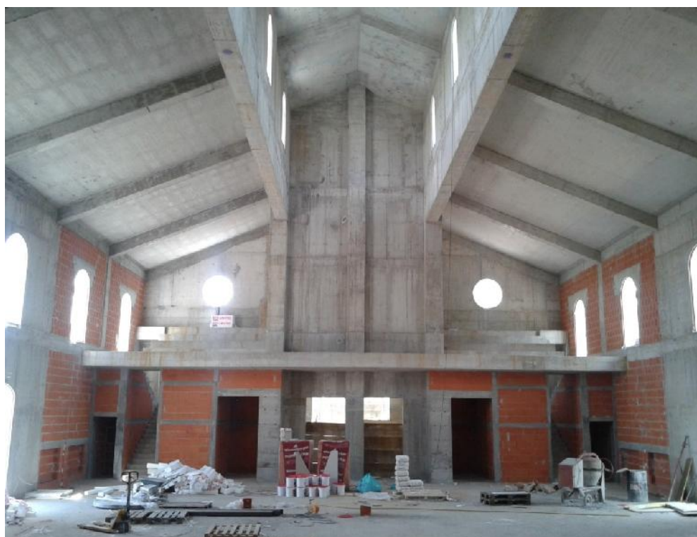
Slika 3. Prikaz unutrašnjosti crkve u izgradnji
