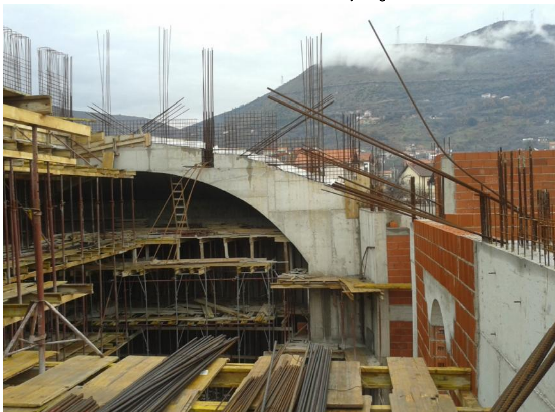
Slika 14. Prikaz izgradnje objekta
