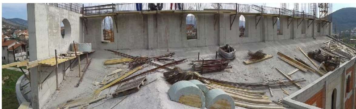
Slika 12. Prikaz izgradnje objekta
