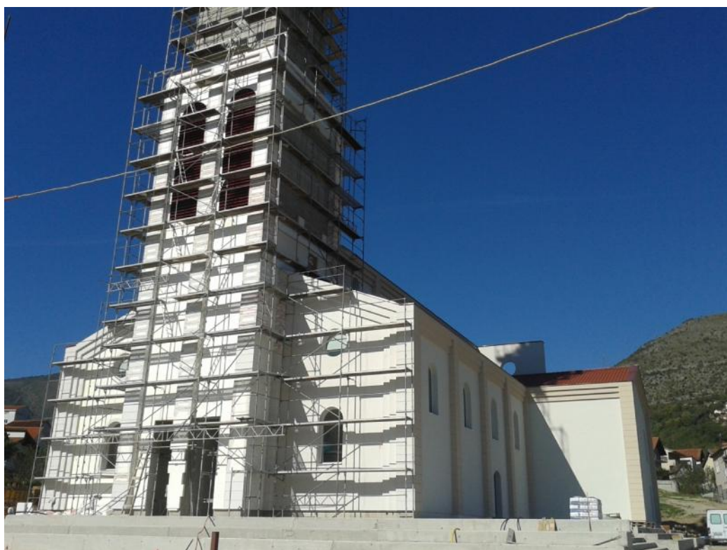
Slika 2. Crkva u izgradnji
