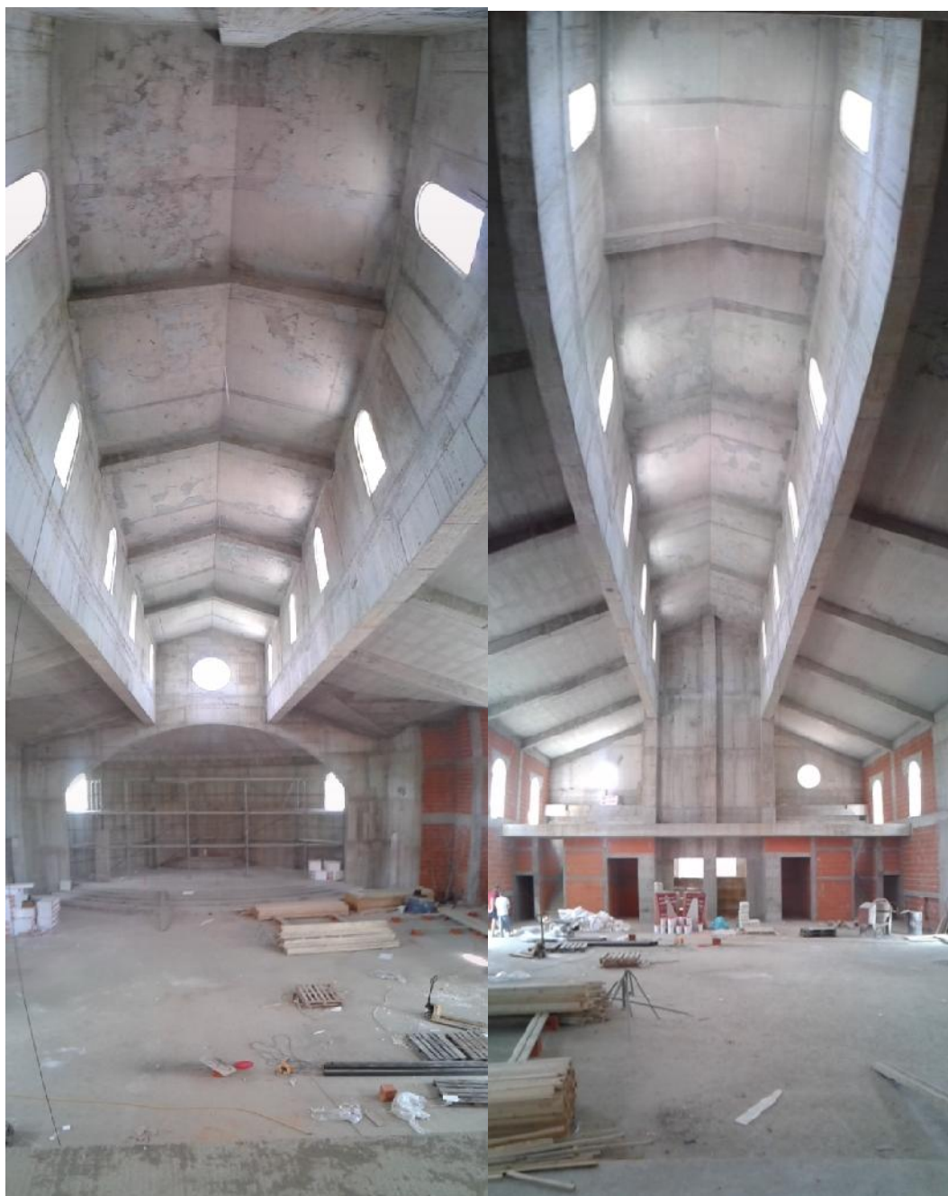
Slika 6. Prikaz unutrašnjosti crkve u izgradnji
