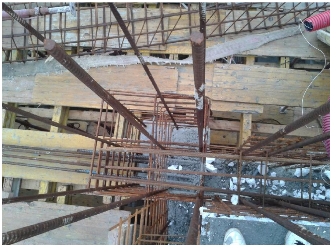
Slika 15. Prikaz detalja kutne armature seizmi kog zida zvonika
