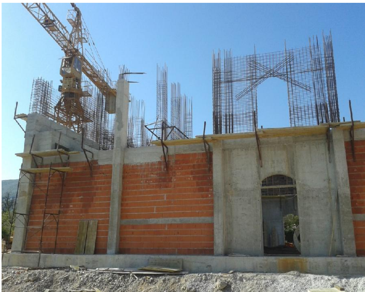
Slika 11. Prikaz izgradnje objekta
