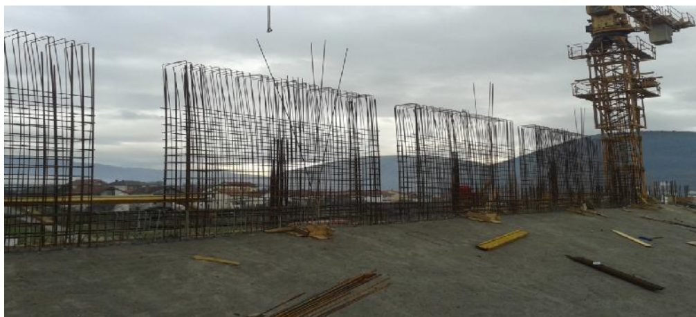
Slika 19. Prikaz armature uzdužnog grednog nosa a (izvana)
