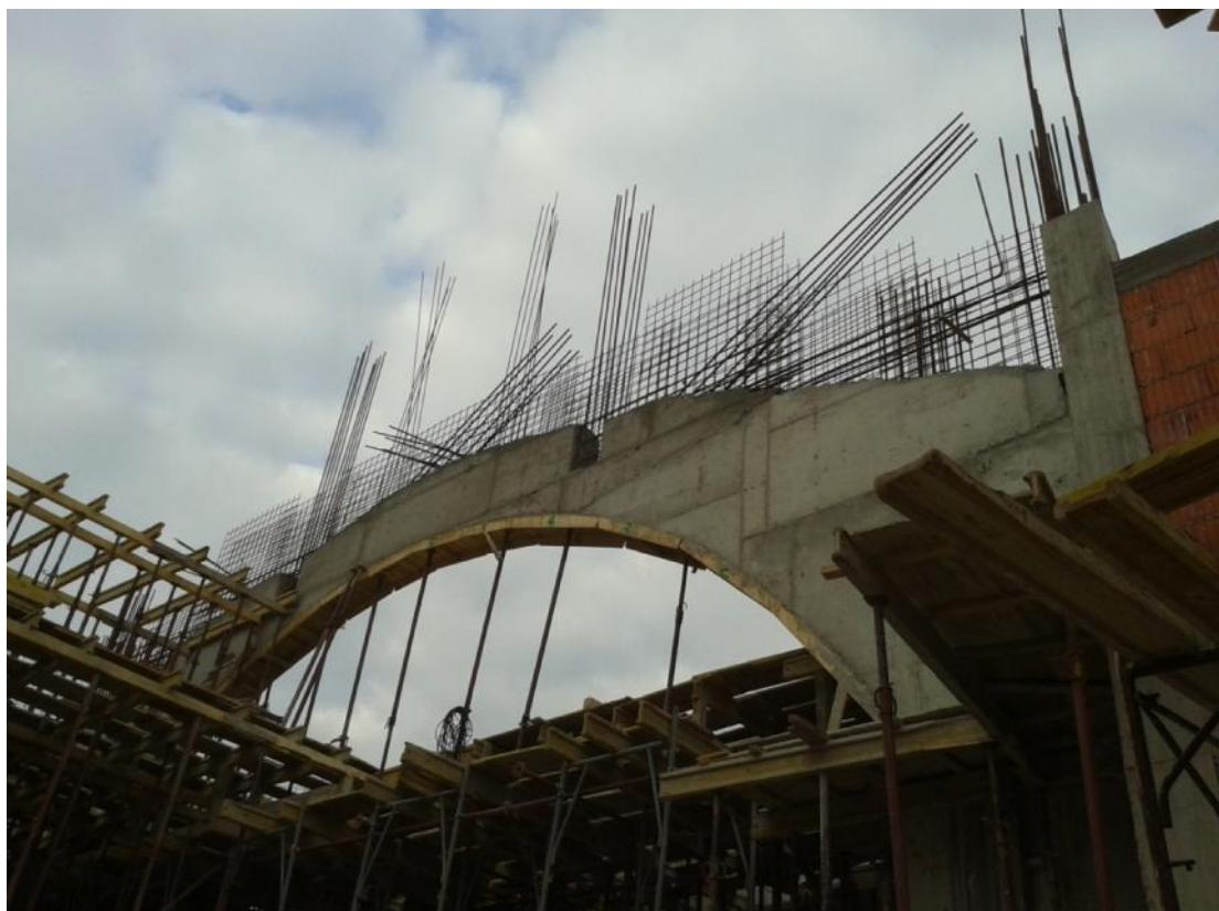
Slika 13. Prikaz armature visokostijjenog nosa a
