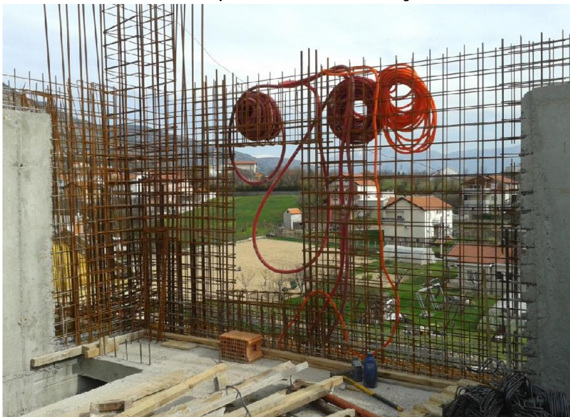
Slika 16. Prikaz armature zida zvonika
