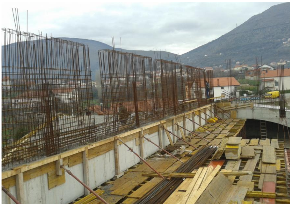
Slika 18. Prikaz armature uzdužnog grednog nosača (iznutra)
