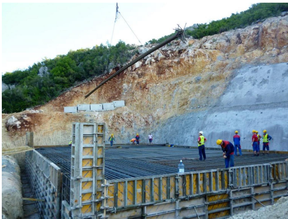
Slika 10. Armiranje i postavljanje oplata naglavnice stuba S1
