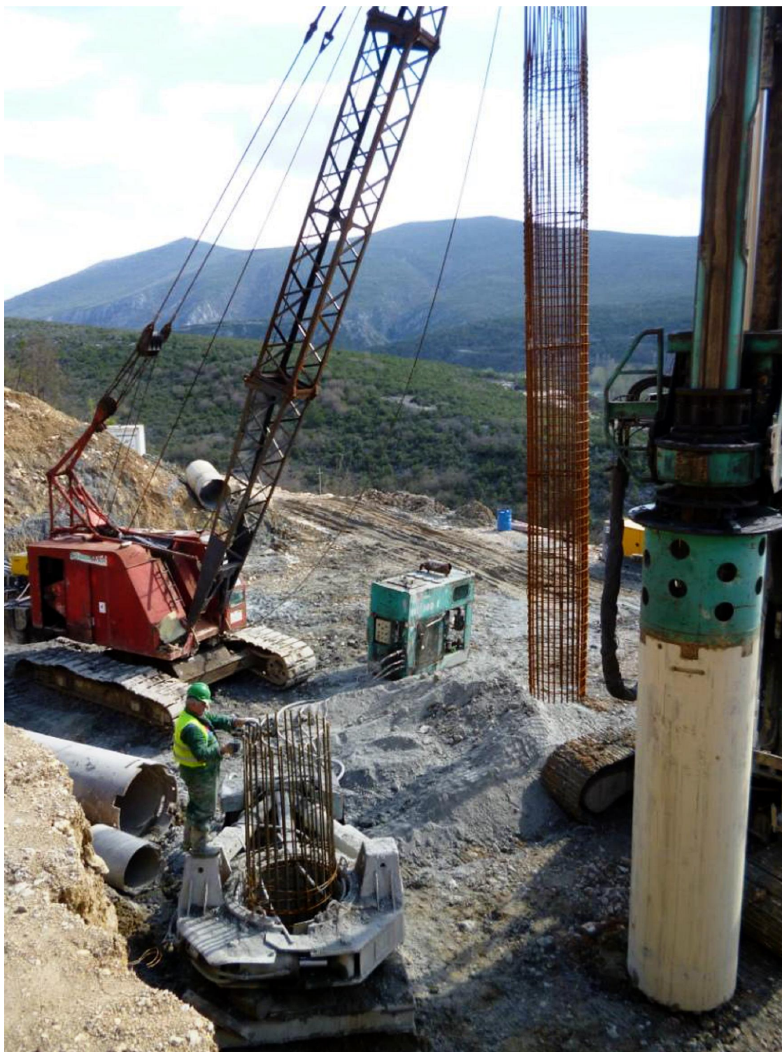
Slika 4. Ugradnja armature i betoniranje pilota
