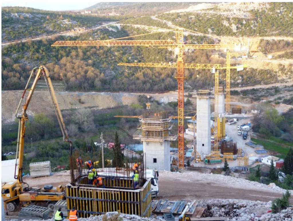
Slika 14. Betoniranje segmenata stubova
