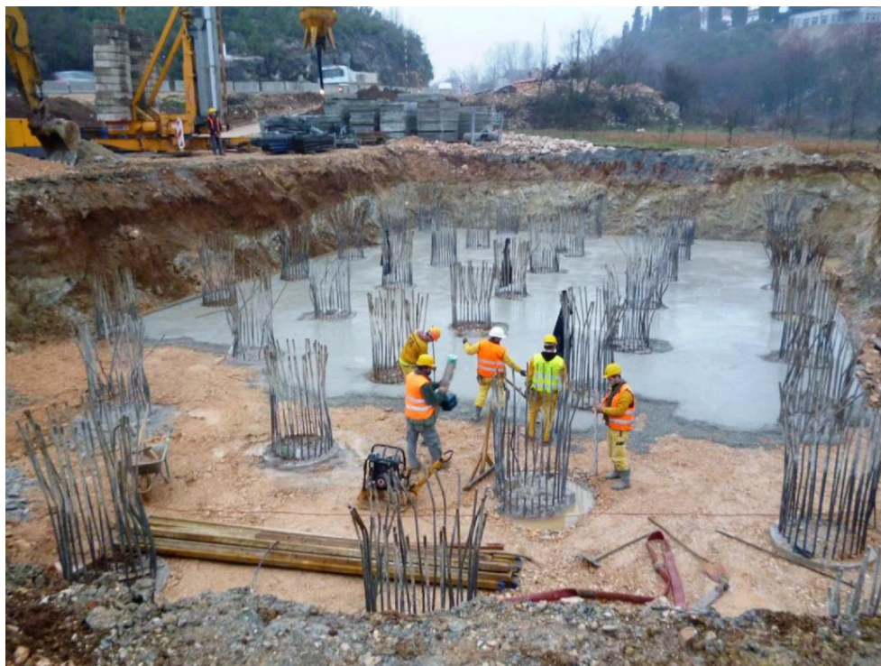
Slika 8. Betoniranje podbetona naglavne ploče
