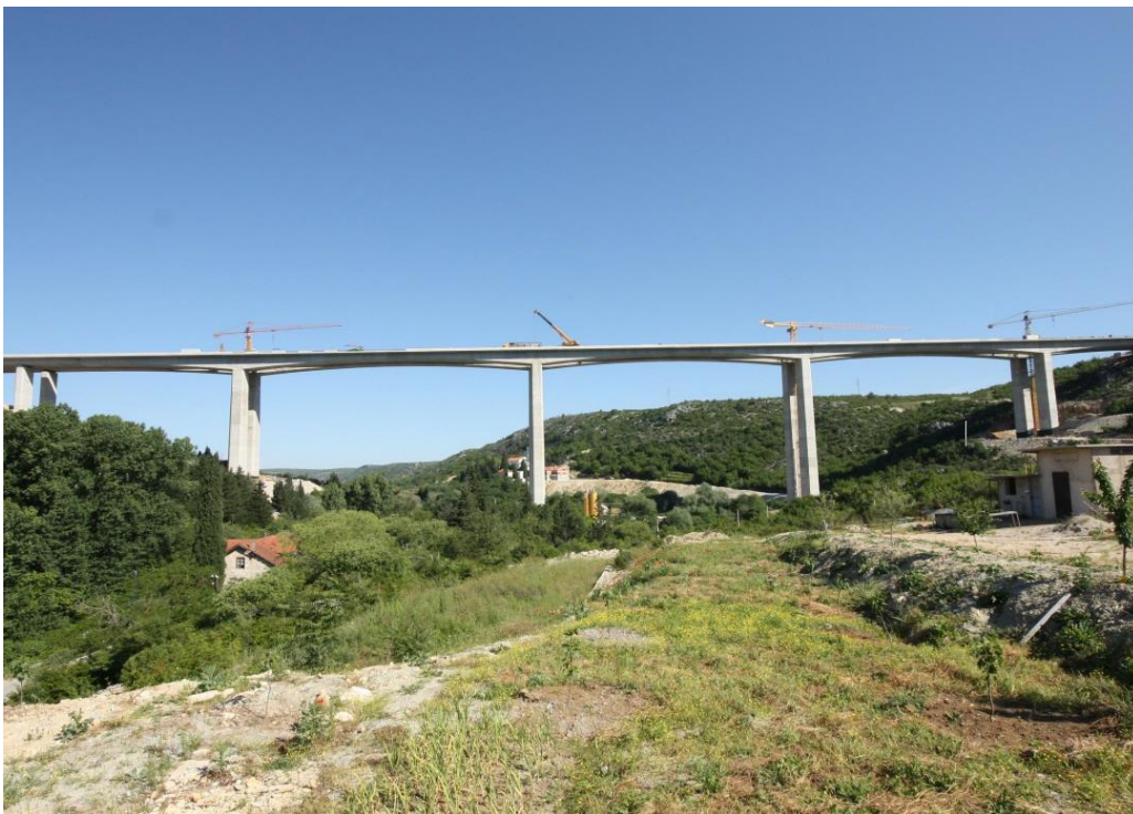
Slika 1. Pogled na most
