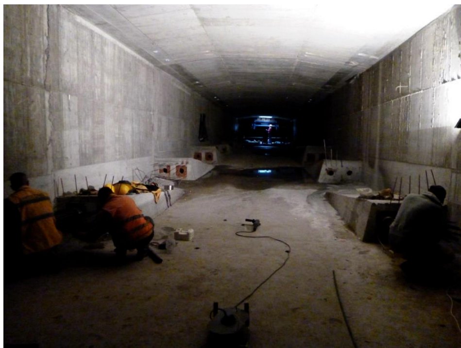
Slika 24. Radovi prednapreznja u sanduku mosta
