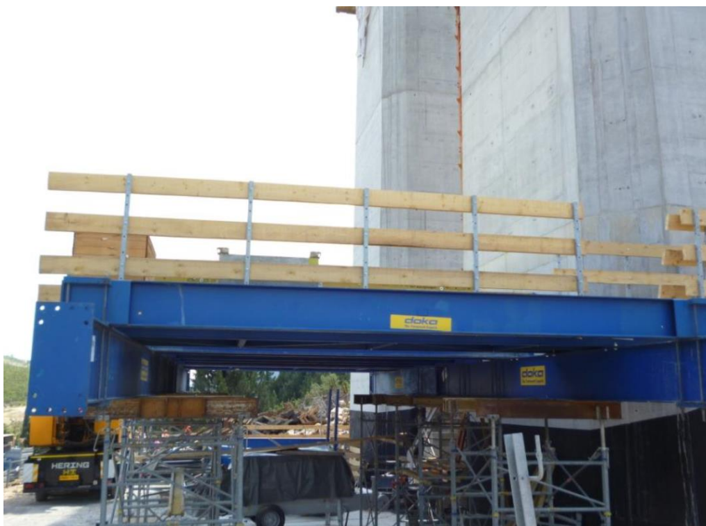
Slika 20. Predmonta0a skele i oplate za slobodnu konzolnu gradnju
