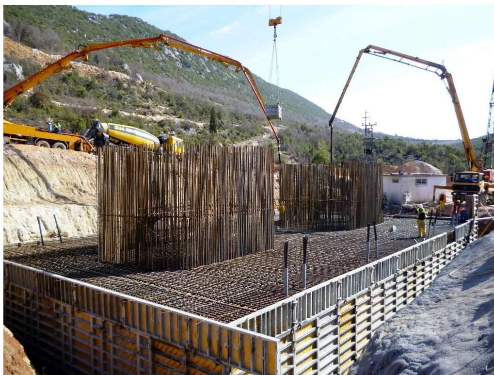
Slika 11. Betoniranje naglavne ploče stuba S2
