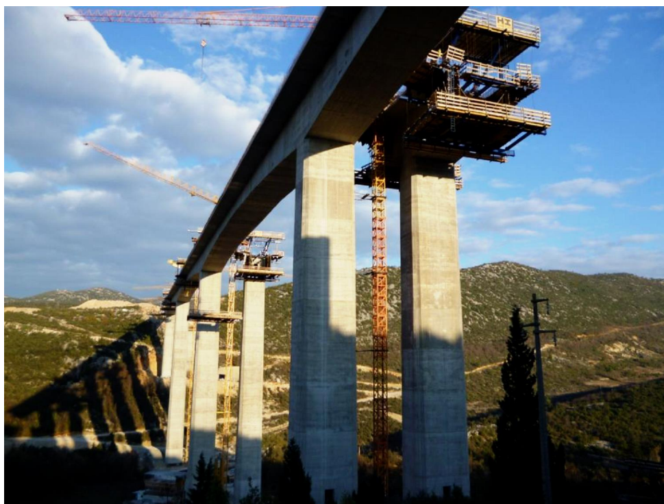
Slika 26. Poetak izgradnje rasponske konstrukcije lijevog mosta
