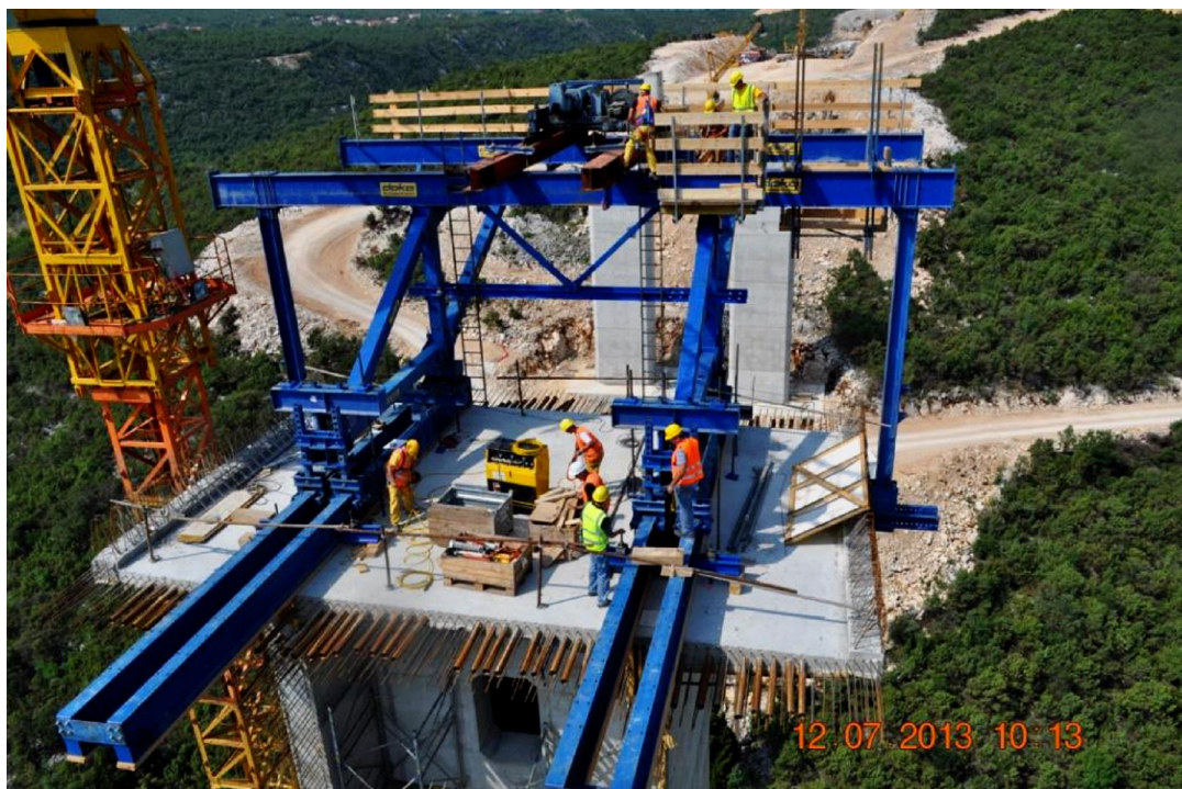
Slika 21. Namontirana "kretka" na stubu S4
