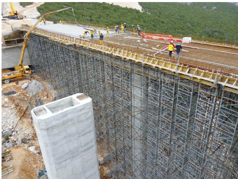
Slika 28. Betoniranje gornje ploče "dijela na skeli" S5D-U6D
