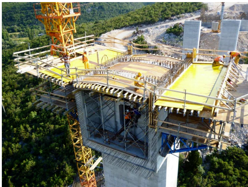
Slika 17. Postavljanje oplata gornje ploče baznog dijela S4D
