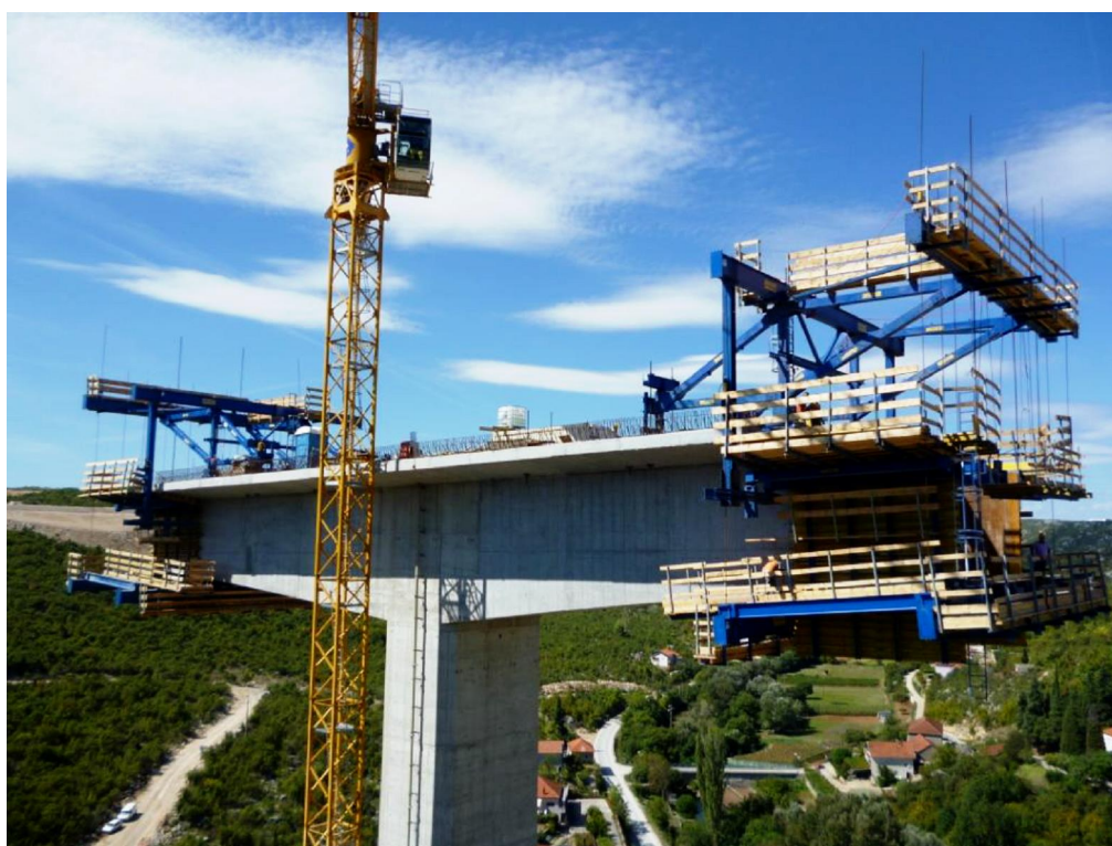
Slika 25. Izgradnja kampade 4 na stubu S3 desnog mosta
