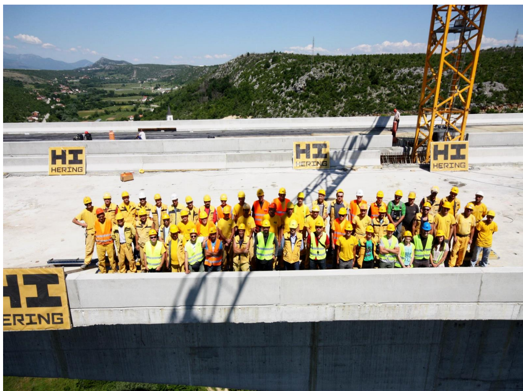
Slika 29. Dovrzetak radova na rasponskoj konstrukciji
