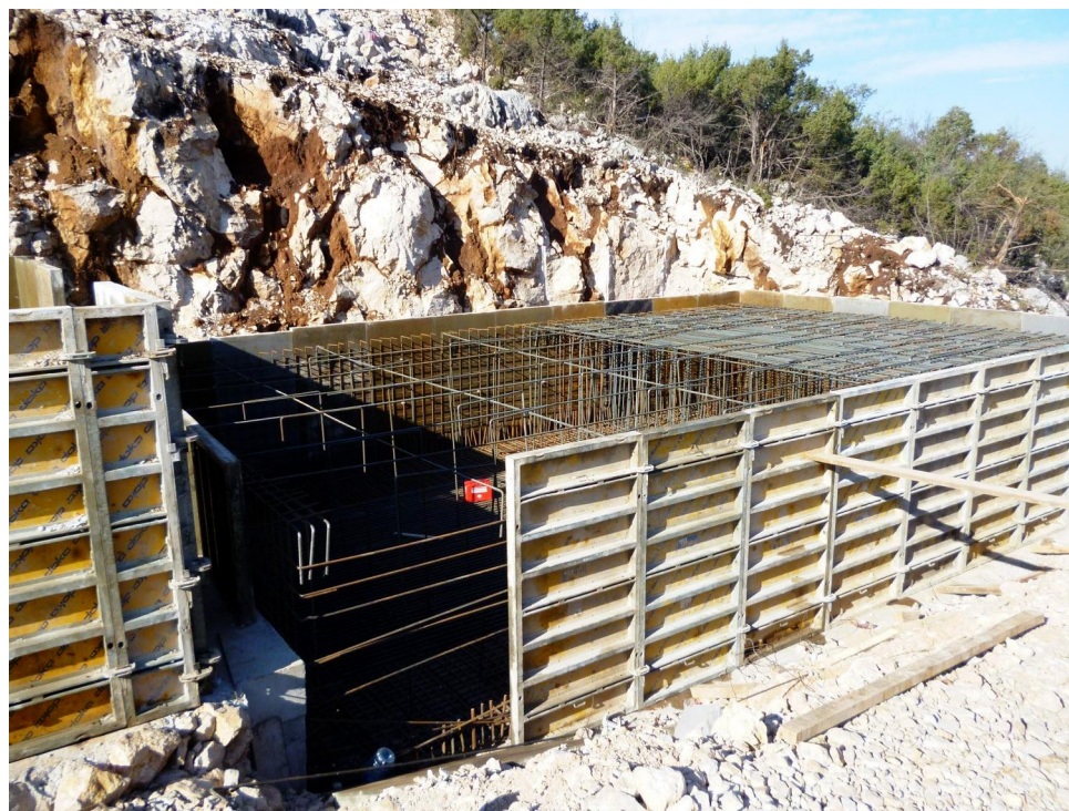
Slika 9. Armiran temelj u oplati stuba S5 mosta Studenica
