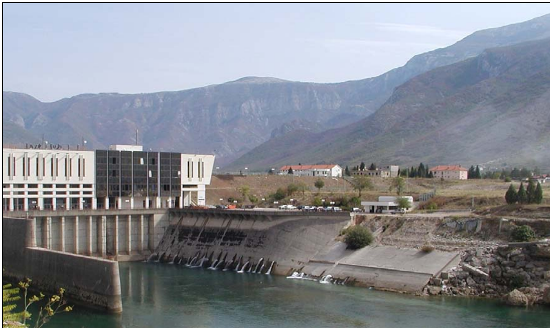
Slika 1. Hidroelektrana Mostar s lijevim zaobaljem [1]
