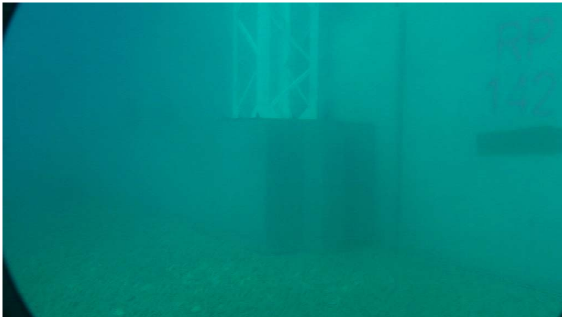
Slika 23. Greda vodilica za polaganje blokova
