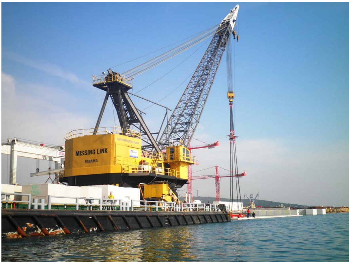
Slika 19. Plovna dizalica 'Missing link'
