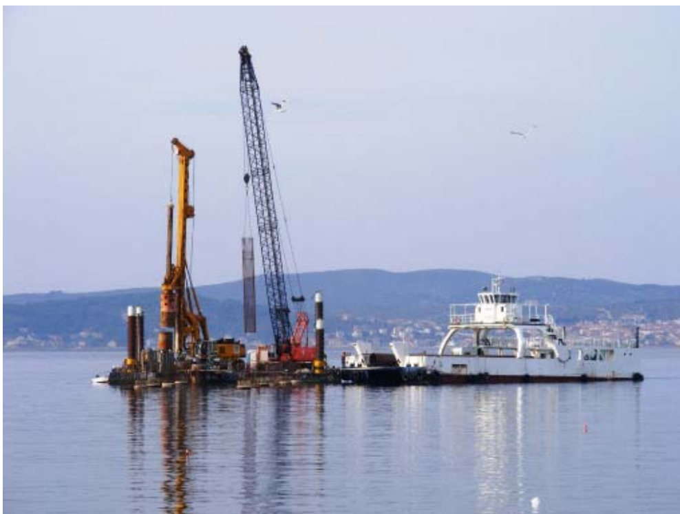
Slika 18. Bušenje pilota
