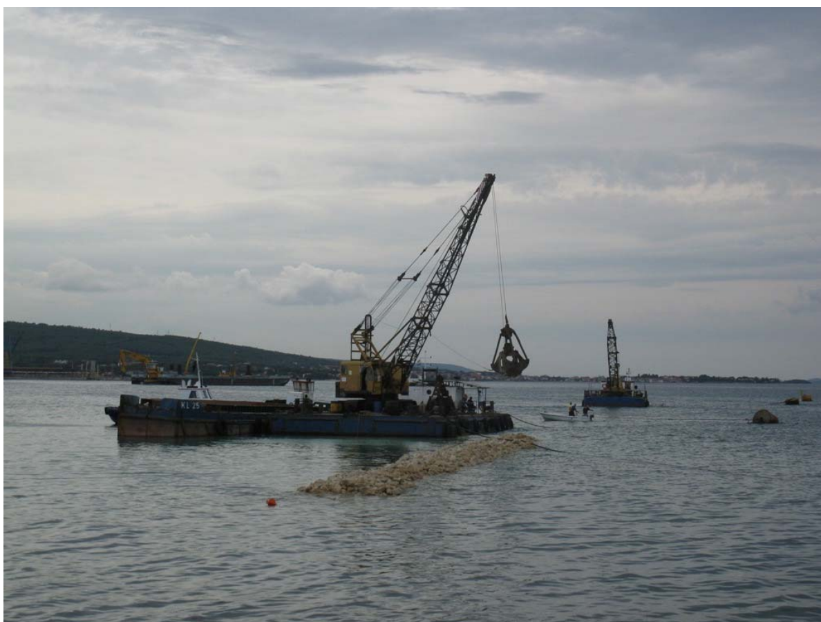
Slika 1. Slaganje obloge sekundarnog lukobrana
