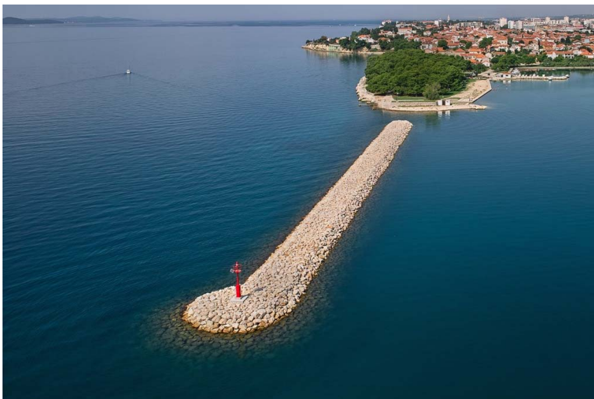
Slika.2 Sekundarni lukobran sa pomorskom signalizacijom
