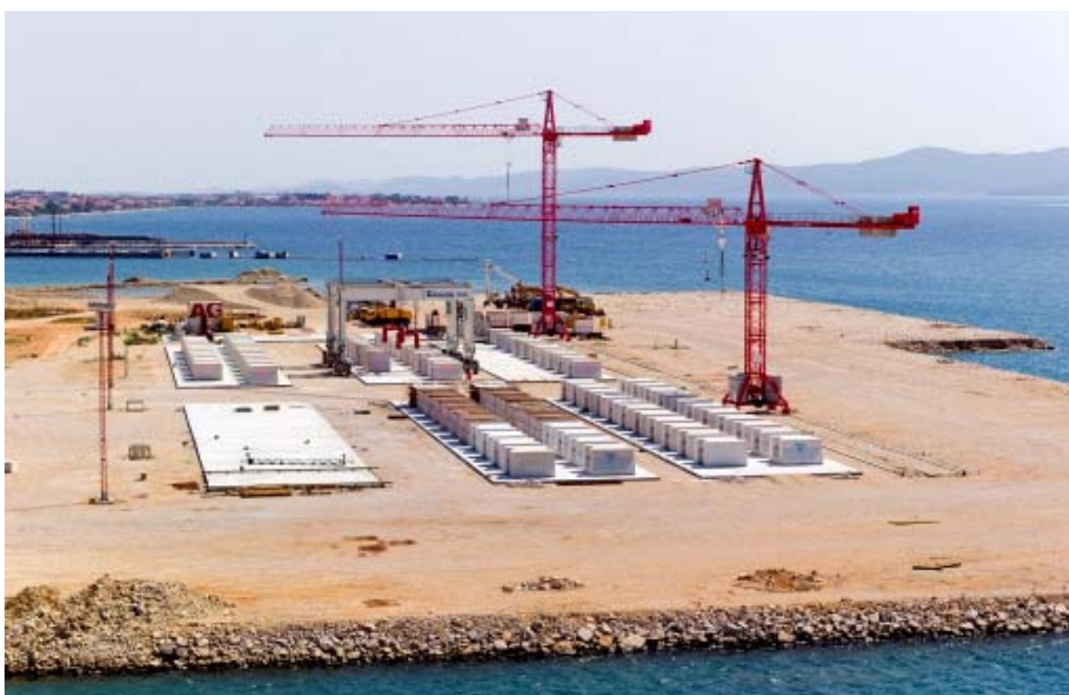
Slika 9. Uređenje pogona za proizvodnju predgotovljenih elemenata
