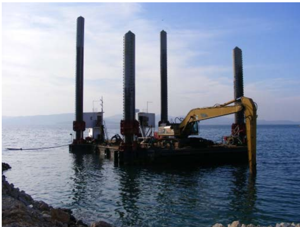
Slika 15. Podmorski iskop morskog sedimenta do dubine -10,5 m
