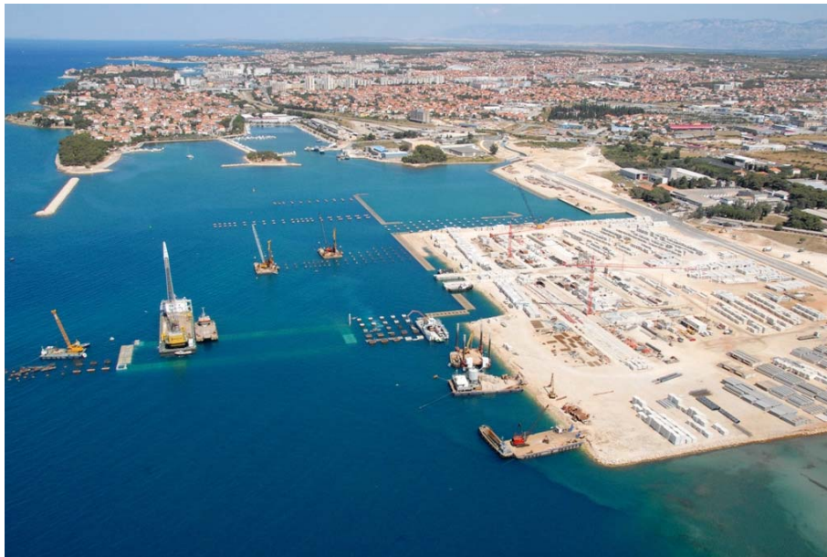
Slika 28. Stanje radova na gradilištu 07/2012, Snimka iz zraka 07/2012
