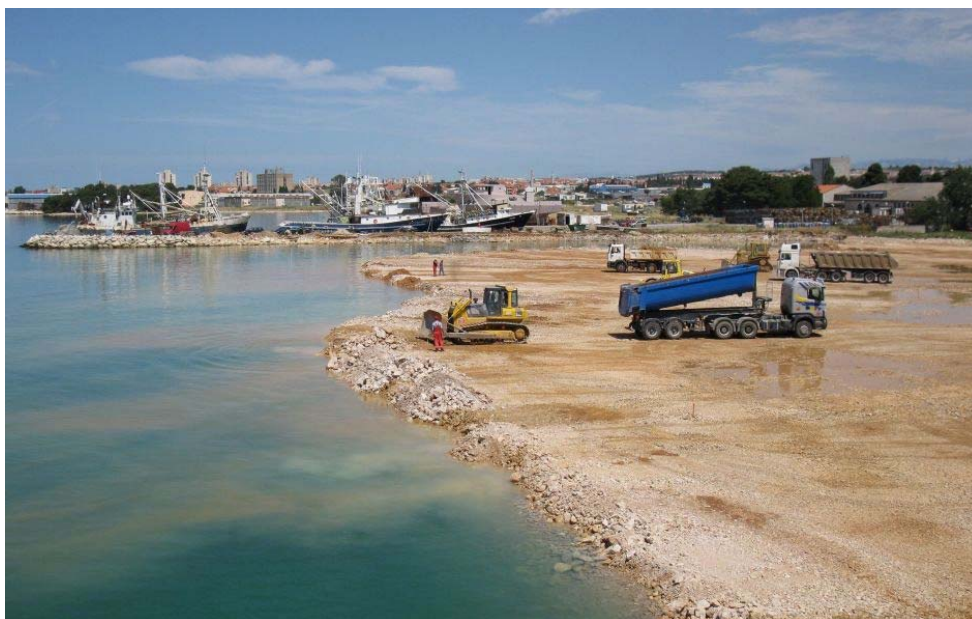
Slika.6 Izrada općeg kamenog nasipa (0 – 500 kg) u moru
