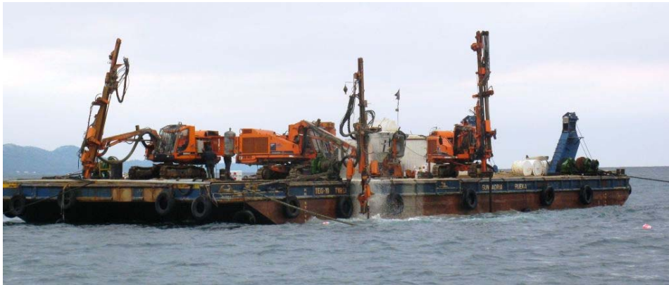
Slika.5. Podmorsko bušenje u rasteru 2,5 x 2,5 m
