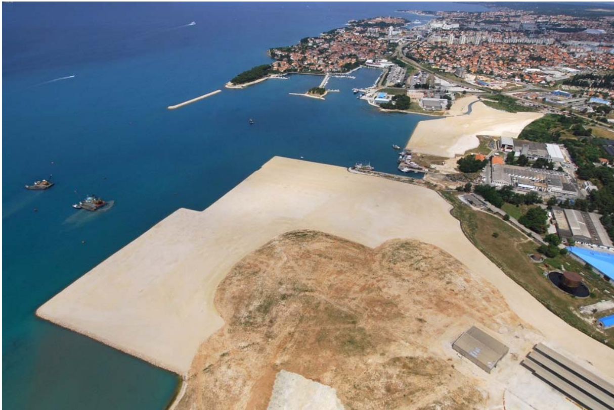
Slika 7. Opći kameni nasipa - trajektni terminal
