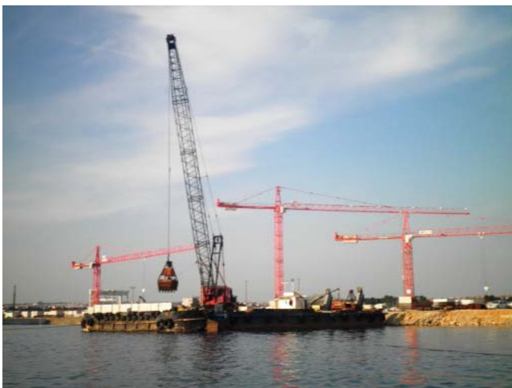
Slika 16. Podmorski iskop morskog sedimenta dubine preko -10,5 m
