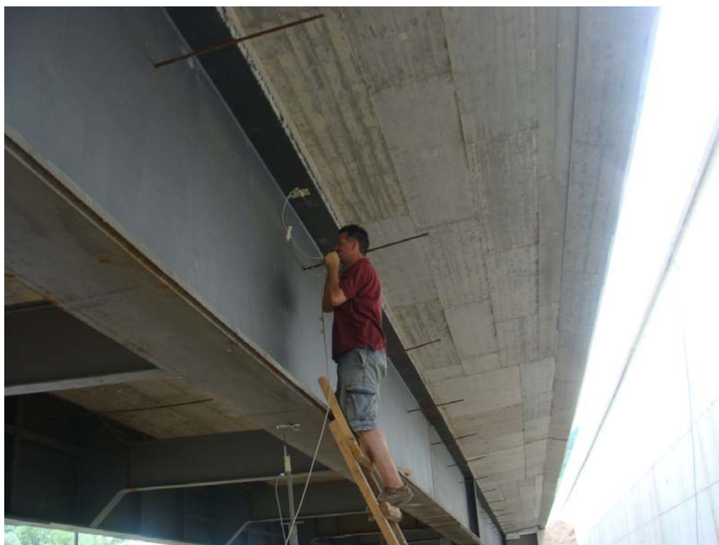
Slika 30. Most RM2 Visoko - Kakanj
