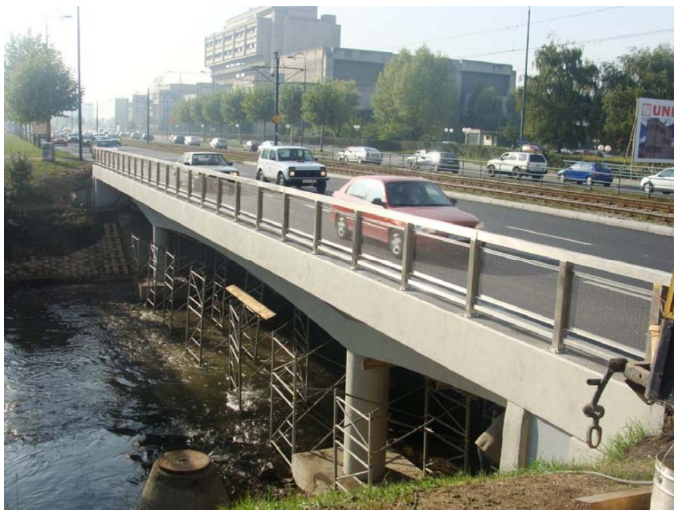
Slika 33. Pogled na most
