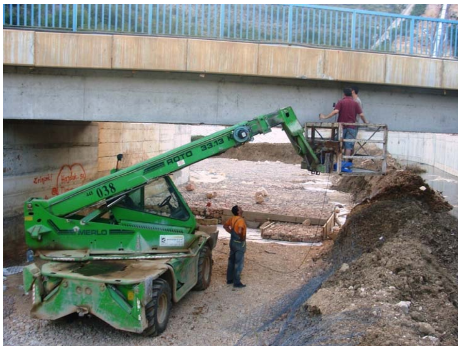
Slika 28. Postavljanje mjernih traka
