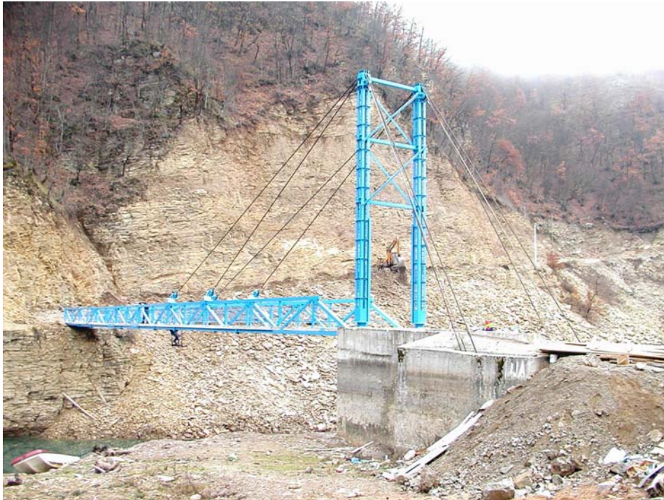
Slika 19. Pogled na most
