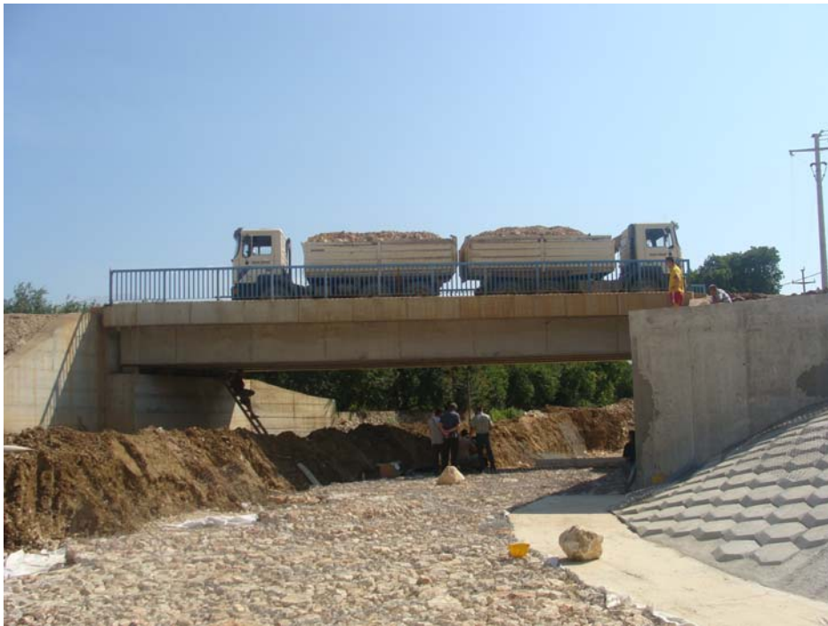
Slika 27. Položaj vozila pri ispitivanju mosta
