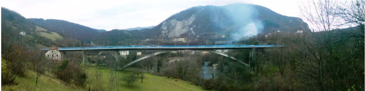
Slika 21. Pogled na most
