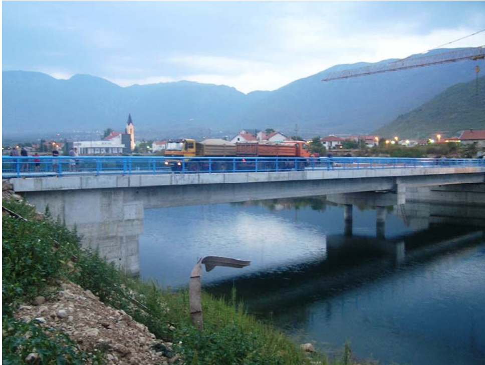
Slika 23. Ispitivanje većeg raspona mosta
