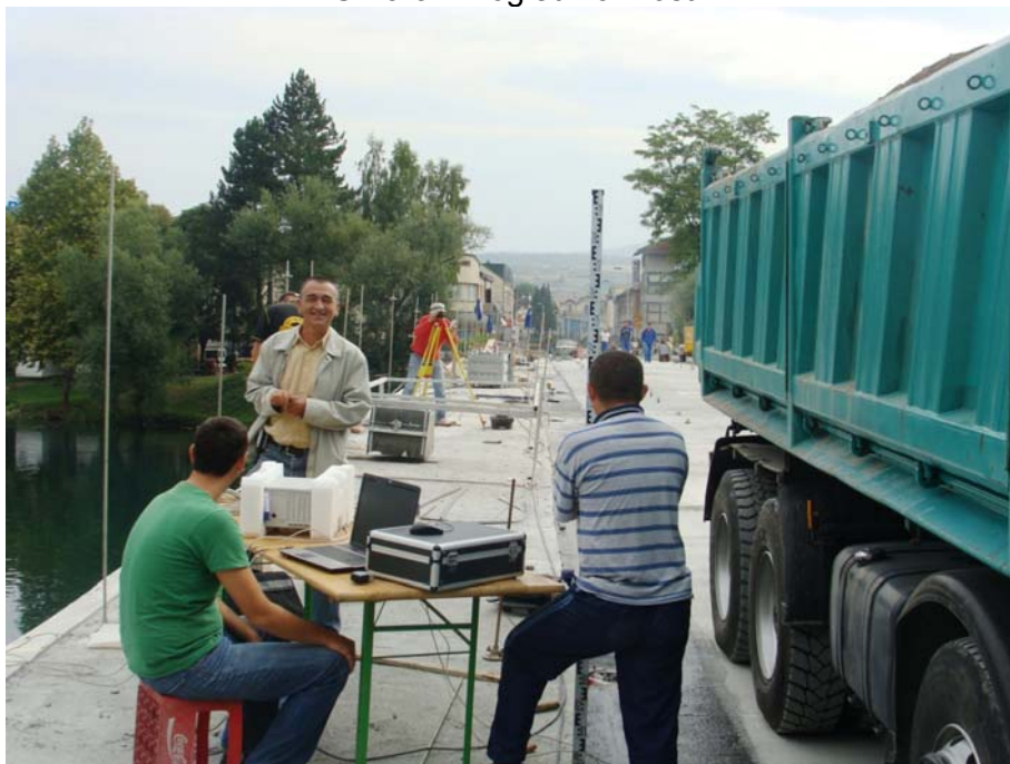
Slika 32. Mjerenje ugiba mosta
