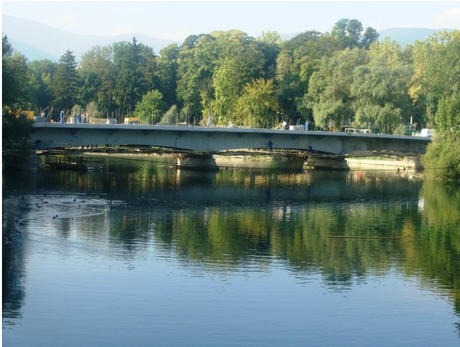
Slika 31. Pogled na most
