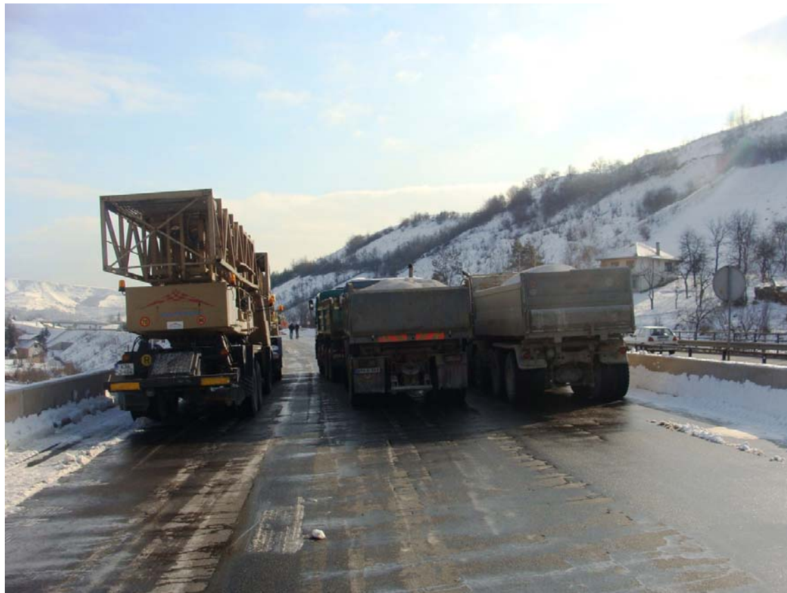
Slika 38. Ispitivanje mosta M4 Bilješevo – Kakanj
