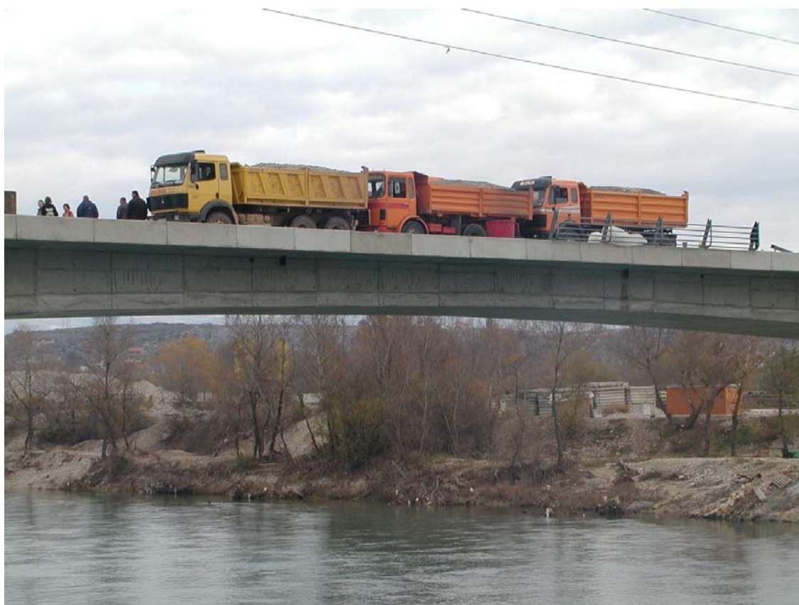
Slika 15. Ispitivanje glavnog raspona mosta
