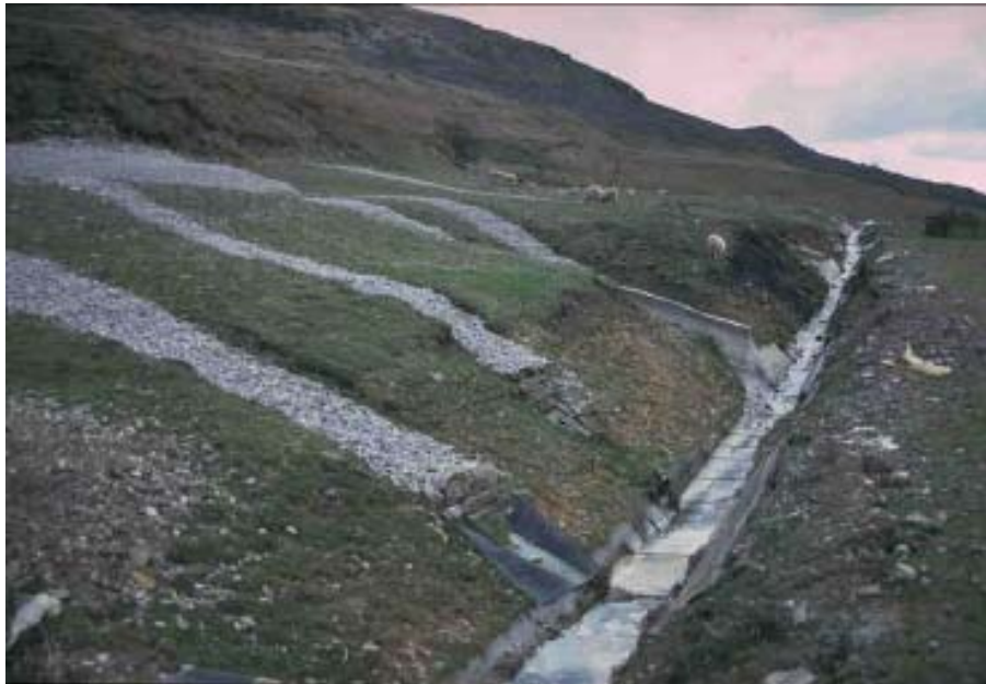
Slika 2. Stabiliziranje kosine kopanim drenovima
