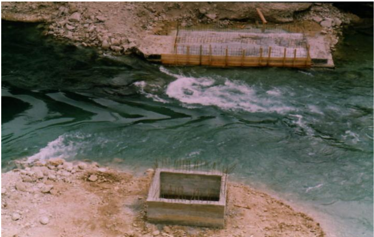
Slika 2. Izrada temelja privremenih stupova
