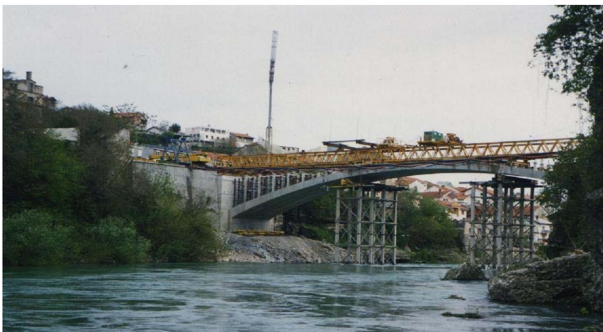
Slika 6. Izrada nadlučne konstrukcije
