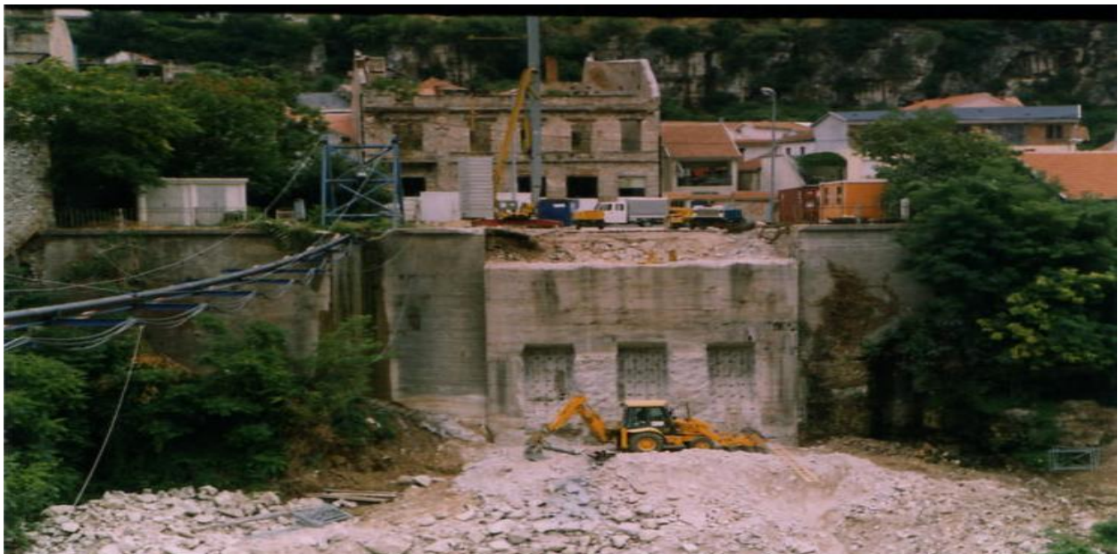
Slika 3. Izrada temelja luka na lijevom upornjaku
