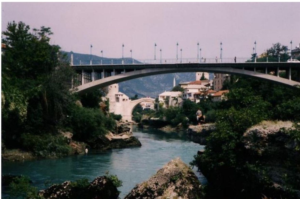
Slika 13. Izgled mosta po završetku radova
