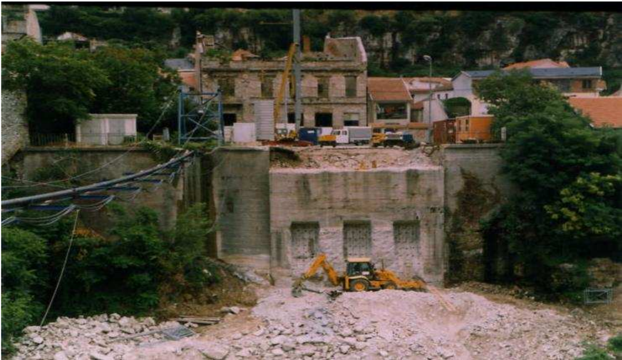
Slika 3: Izdelava temelja loka na desnem oporniku
