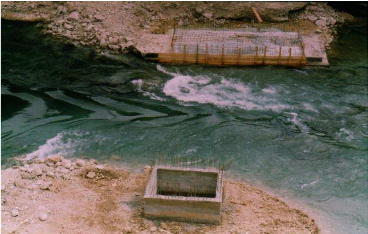
Slika 2: Izdelava temeljev začasnih stebrov
