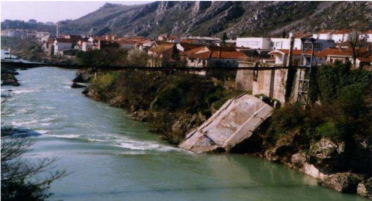
Slika 1: V vojni porušeni most
