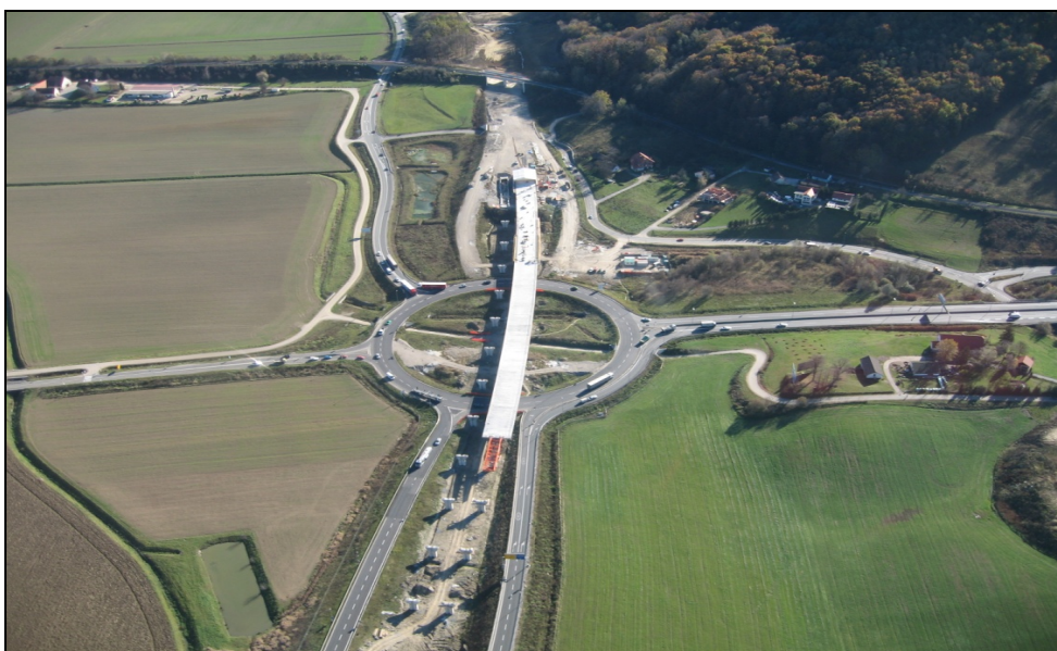
Slika 1: Viadukt Rondo u toku izgradnje
