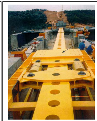
Slika 13: Hidraulička oprema za postepeno potiskivanje sa ošupljenim čelični nosačom koji je sinhronovezan na hidrauličku opremu
