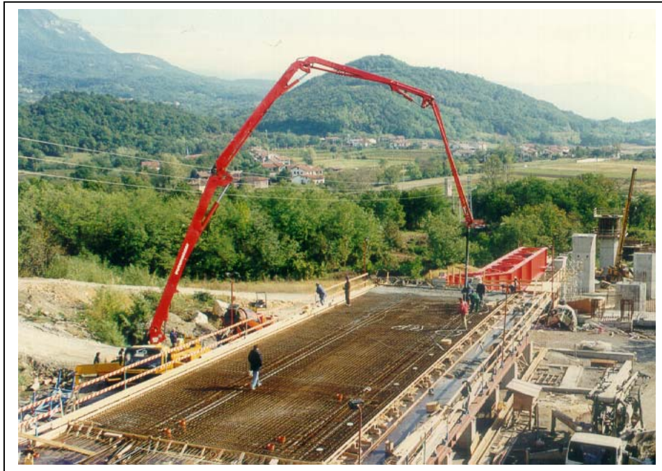
Slika 3: Platforma za izradu rasponske konstrukcij
