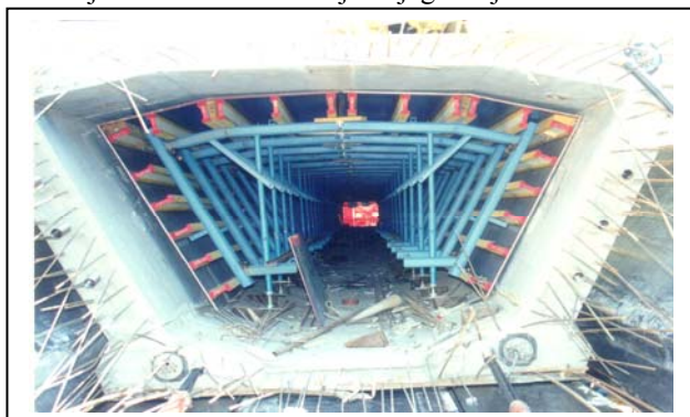
Slika 5: Poprečni presjek rasponske konstrukcije u oplati
