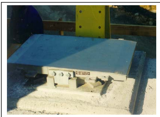
Slika 20: Šema konačnog i privremenog ležišta
